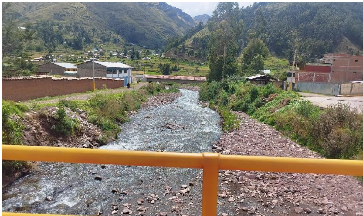
FIGURA N° 02: SE MUESTRA EN LA IMAGEN EL CAUSE COLMATADO Y TAMBIEN SE APRECIA TALUDES NATURALES Y VIVIENDAS ASENTADAS EN LA MARGEN IZQUIERDA Y DERECHA DEL RIO CASUIRA (RIO CHEJHUIÑA).
